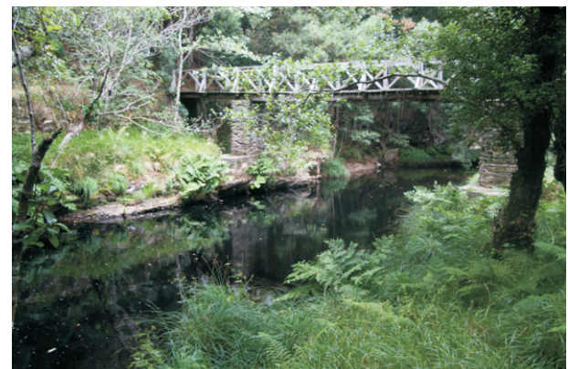
Ponte no Refuxio de Cubelas
